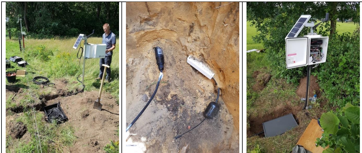
Figuur 7 a) Installatiewerkzaamheden in Hengelo, b) tensiometer en bodemvochtsensor in profielkuil, c) meetkast met datalogger.
